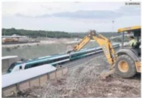
A MARCHAS FORZADAS. Mientras se llevaba a cabo el recorrido del Tren Maya en el tramo inaugurado, los trabajadores continuaban con las obras.
