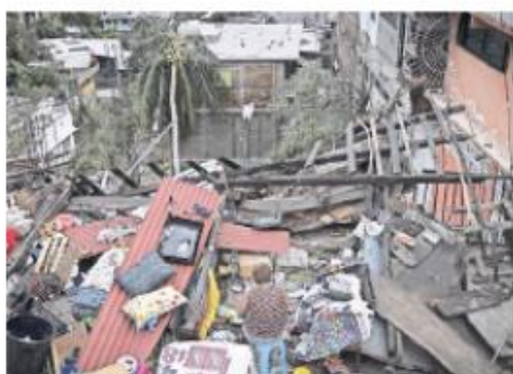
DESTRUIDOS CAUSADOS por el huracán Otis en Acapulco
