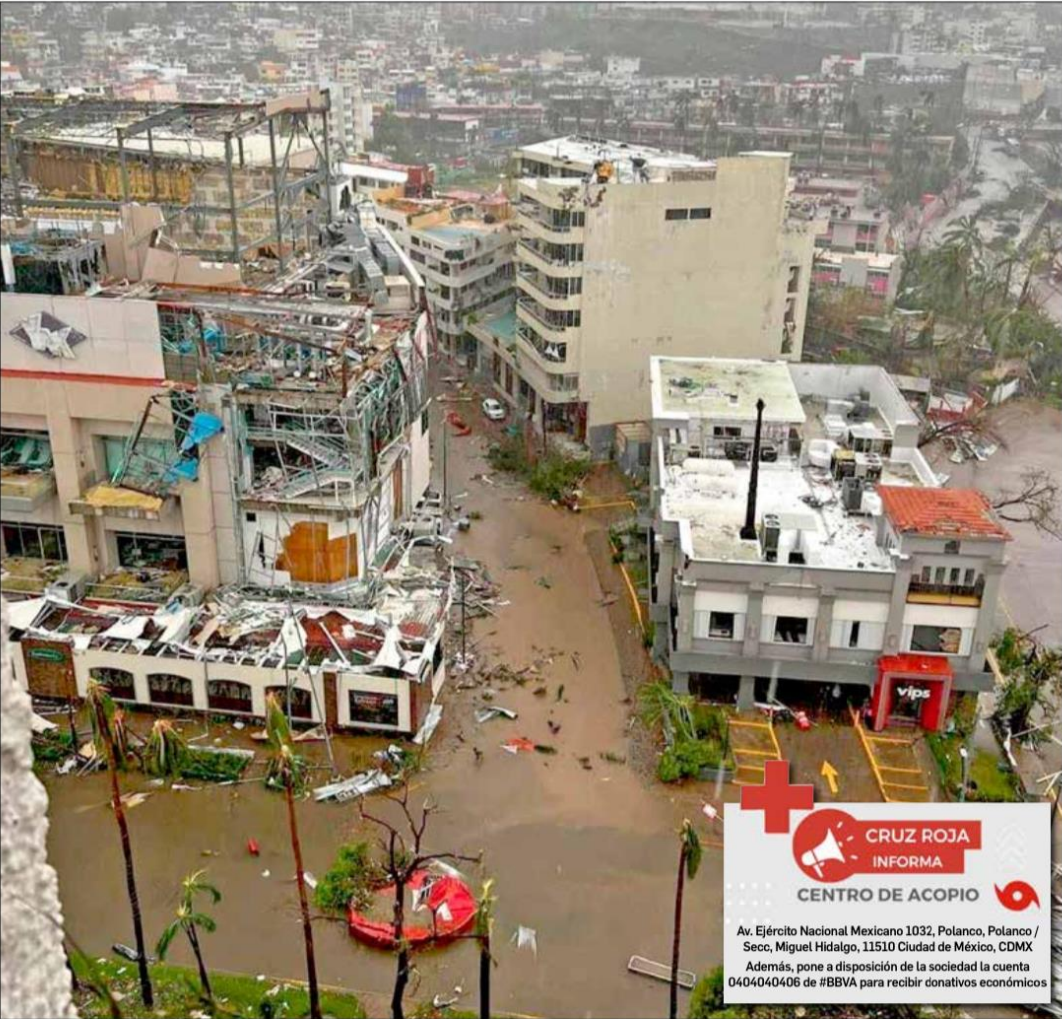
▲ Cientos de inmuebles del puerto de Acapulco, entre hoteles, plazas comerciales, hospitales y viviendas, sufrieron severos daños por el paso del huracán Otis. Hasta anoche se desconocían los estragos en las zonas populares. Foto tomada de redes sociales
