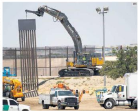
OBRAS. Pese a que algunos sectores avalan la construcción del muro fronterizo por parte de Estados Unidos, la administración de Biden se dice en contra.
