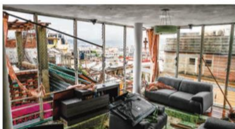
Hoteles y departamentos sufrieron severos daños tras el meteoro.
