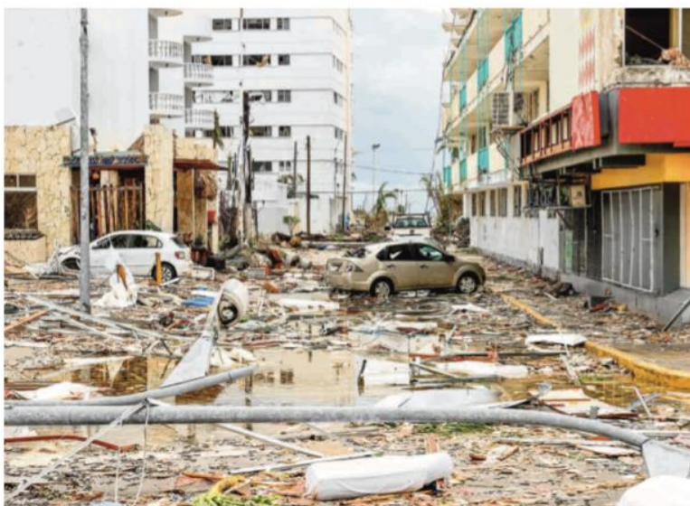
Los daños causados por el huracán generarán fuertes impactos en la actividad turística del puerto de Acapulco.
