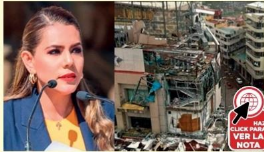
LA MAYORÍA de la infraestructura de los hoteles de Acapulco quedaron destruidos por el Huracán Otis.
