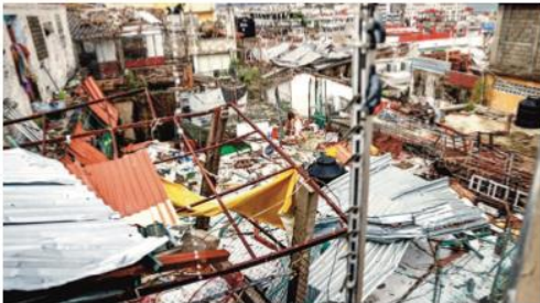
Daños. El paso avasallador del huracán dejó muertes y destrucción a su paso; ya se trabaja en la recuperación.
