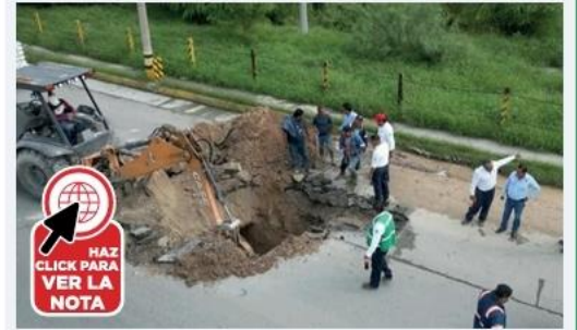
LA FUGA fue reparada y el pozo relleno con material especial para que no haya hundimientos posteriores.
