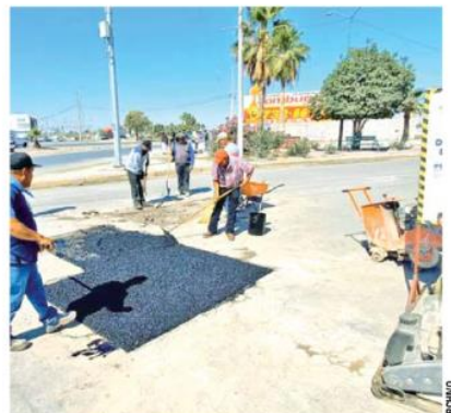
La obra que el Municipio ejecuta en bulevar San Carlos (por donde pasa una de sus líneas), se trata de una pavimentación necesaria.
