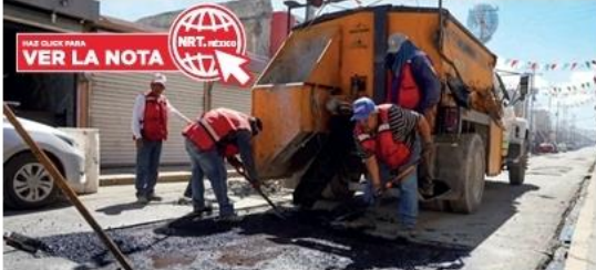
A TRAVÉS de diversas cuadrillas, trabajadores municipales colocaron alrededor de 530 metros cuadrados de carpeta asfáltica.
