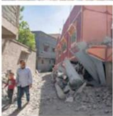
DESTRUCCIÓN. Tras el sismo, los habitantes salieron de sus casas para resguardarse en la vía pública. Los daños aún son evaluados por las autoridades.
