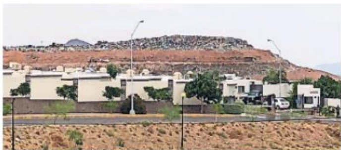
FRACCIONAMIENTO CONSTRUIDO junto al terreno selvático
