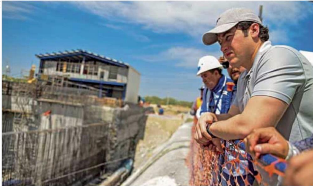
Supervisión. El mandatario estatal visitó las obras del acueducto El Cuchillo II, que se inaugurará el próximo 13 de septiembre con el presidente AMLO. /CONTESIA
