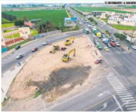
INTERVENCIÓN. Las obras comenzaron el pasado miércoles y han complicado los recorridos de algunas personas que circulan por esa zona de la metrópoli.
