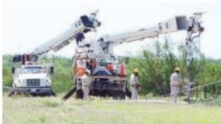
■ Siete cuadrillas de CFE División Golfo Norte zonas Nuevo Laredo y Piedras Negras y cuatro externas trabajan en la reparación de postera que derribó un tornado en Hidalgo.
