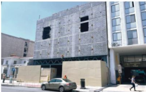
Obra. Si bien estuvo suspendida por un tiempo, la construcción de lo que será una zapatería Moderna se retomó.
