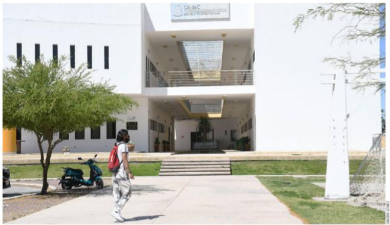
Educación. La ciudad lagunera por excelencia destaca en seguridad, infraestructura de inmuebles y servicios, lo que la convierte en un polo de inversión.
