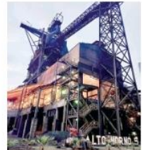
Denuncian riesgo en las áreas de trabajo por falta de equipo de protección.
