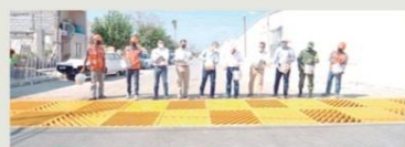
MIGUEL RIQUELME ENTREGÓ la obra del Colector Pluvial para la Zona Centro de Frontera.
