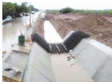
■ Los drenes se construyen en las colonias La Misión y Santa Martha.
