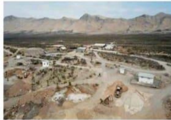
EL PASADO 10 de julio se registró el derrumbe en la Mina "La Pasión", que cobró la vida de dos trabajadores.
