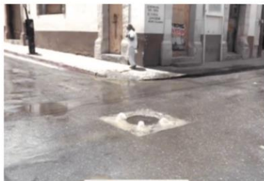
Mal aspecto. La fuga de aguas negras arrecia después de cada lluvia; se ubica en el cruce de las calles de Lerdo y Acuña.
