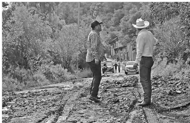
Desde muy temprano se empezó a trabajar con maquinaria para empezar a abrir esa vía; no se reportaron personas lesionadas.
