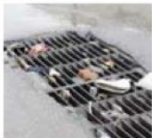
La principal causa de los estragos causados por la lluvia es el exceso de basura que se acumula en las rejillas.
