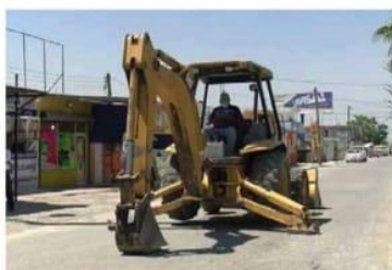
LA OBRA DE la calle Porfirio Díaz es uno de los proyectos donde se trabaja en sinergia con SIMAS.
