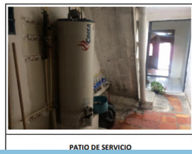
PATIO DE SERVICIO
