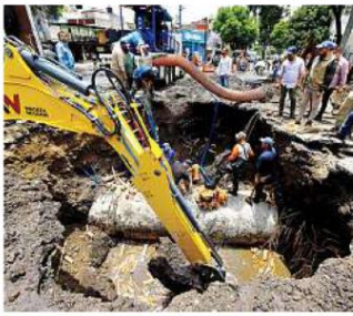
Personal de Sactem y Protección Civil trabaja en la reparación del socavón que se abrió en Canal de Miramontes.
