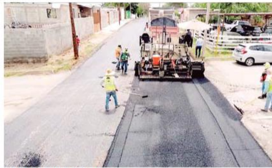
Trabajan en obras de pavimentación en Los Montes.
