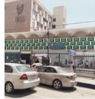
Problema. El trabajo en la clínica 7 del IMSS se complica por las fallas del aire acondicionado.
