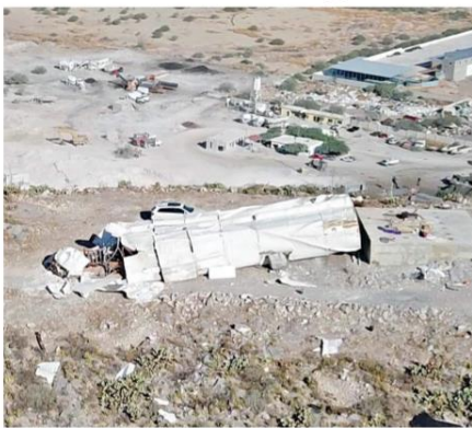
Según los primeros reportes, la estructura de la Virgen del Desierto se desplomó a causa de las fuertes rachas de viento registradas la noche del jueves en la ciudad de Gómez Palacio.
