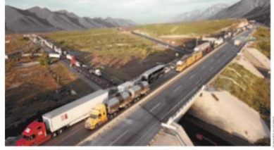
Autopista. La Sal-Mon realiza adecuaciones para mejorar la seguridad de los viajeros, con tecnología de punta.
