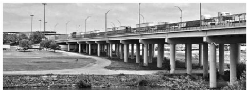
La modernización será en todas las instalaciones de la aduana de Piedras Negras y el Puente Internacional número II.
