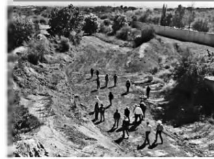
se contemplan obras como la canalización de arroyos, control y regulación de escurrimientos y construcción de sistemas pluviales.
