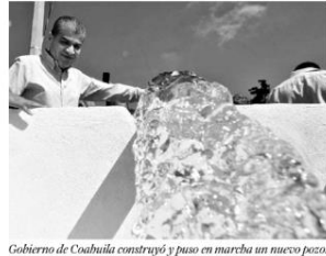
Gobierno de Coahuila construyó y puso en marcha un nuevo pozo.
