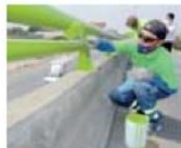
Recientemente se pintaron los banderales del puente Campanares.
